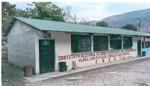
Foto 1: Edificio Escolar a remozar
