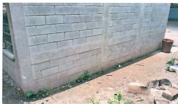
Foto 4: Reparación de repello y pintado de paredes interior y exterior
