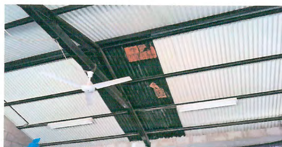
Foto 2: Cubierta de láminas
